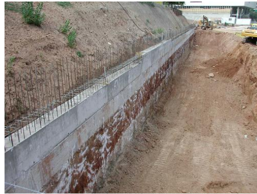
Muros de Contención (cimentación) - Construmatica
