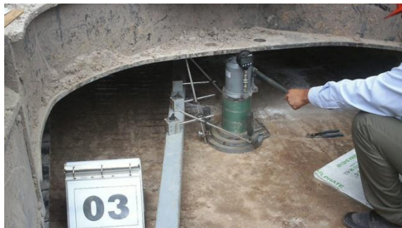
Prueba de Carga con Placa-Placas – Geointegra. (2016, 25 julio).
